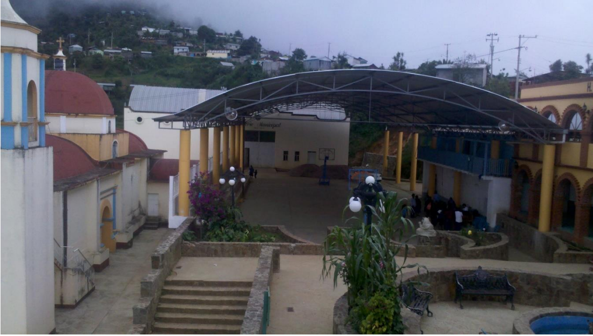
Auditorio en la explanada municipal de San Marcial Ozolotepec.
