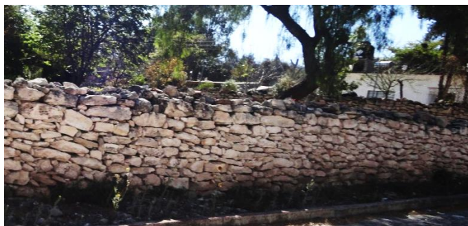
Figura 20. Obra de retención de suelo con cascajo y piedra.
