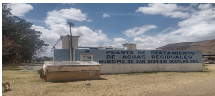
Figura 34. Planta tratadora de aguas residuales en San Dionisio Ocotlán
