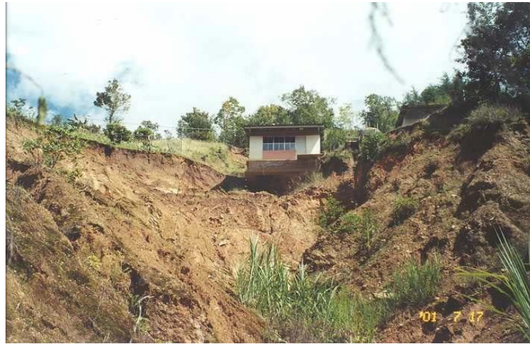
Fotografía No. 45.- Construcción de un jardín de niños por mala planeación se realizó sobre el cauce de un arroyo, fotografía tomada en la Agencia de Policía Patio Iglesia del municipio de Huautla de Jiménez, Oax.
