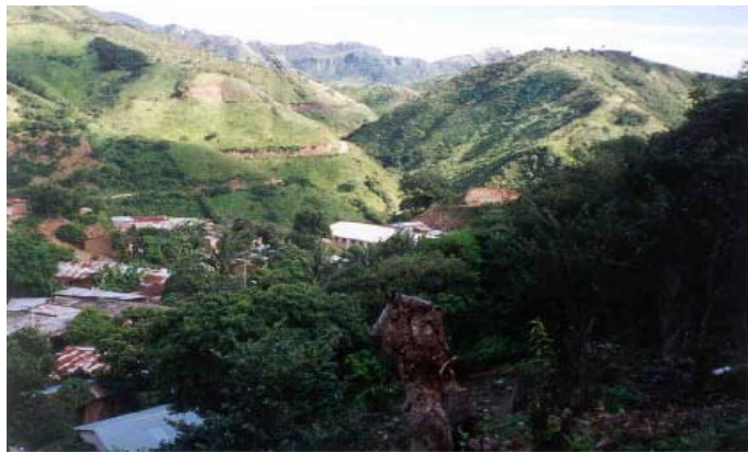
Fotografía No. 37.- Caída de rocas asociado la zona de inestabilidad de Guevea de Humboldt, Oax.
