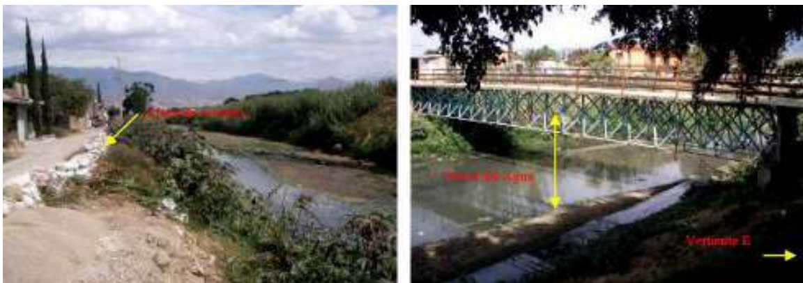
Figura 5.3.10. Bordo de contención y cauce del río Salado en la agencia Cinco Señores del municipio de Oaxaca de Juárez.
