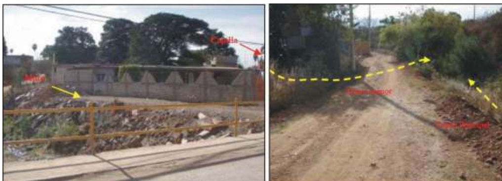
Figura 5.3.2. Dos vistas que muestran los cauces que atraviesan por zonas habitadas en la agencia Viguera.
