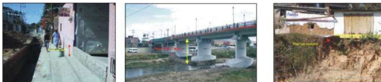
Figura 5.3.6. Las dos fotografías de la izquierda muestran zonas de inundación y cauce del río Atoyac. La de la derecha muestra un detalle de las características constructivas de algunas viviendas.
