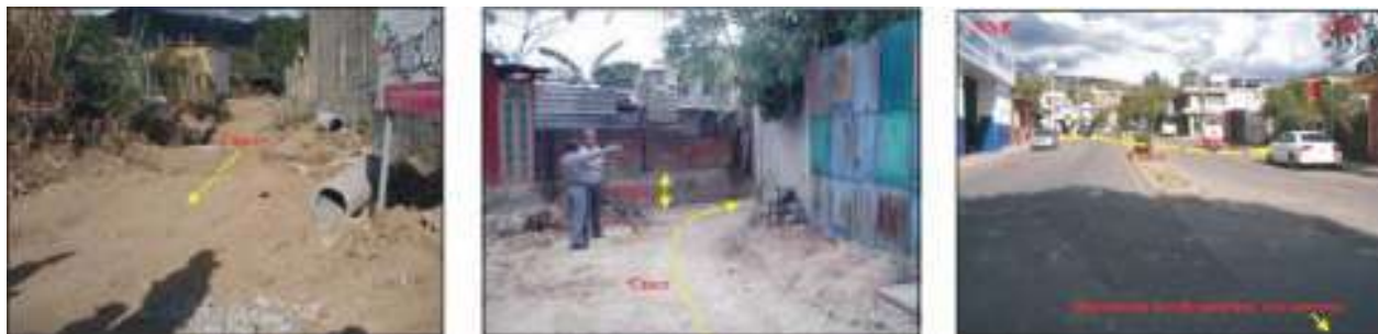
Figura 5.3.3. Tres vistas diferentes de cauces de arroyos invadidos por zonas habitadas.
