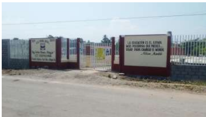
Primaria Victor Bravo Ahuja, en Puente Madera.
