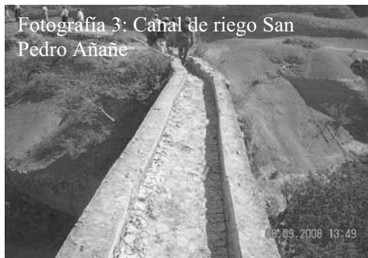
**Canal de riego:** En la comunidad de San Pedro Añañe existe un Canal de Riego Rustico muy deteriorado que es utilizado para regar 6 hectáreas de terreno. Este canal se asolva en temporada de lluvia, para rehabilitarlo se hace un tequio en temporada de sequía para poder utilizarlo.
