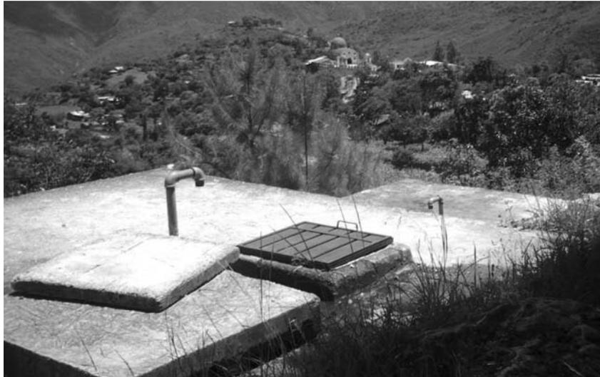
**Figura 8.** Tanques de almacenamiento de agua de la población.
