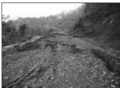
Figura 9. Carretera a Sosoltepec en mal estado
