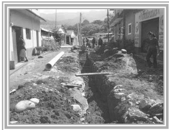
**Imag. 17. Construcción del drenaje.**
