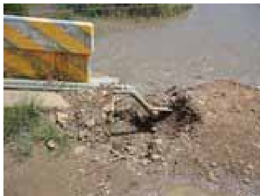
Figura 6.-Tubería de agua
