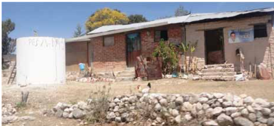
Fig.24 Cisternas de Ferrocemento
