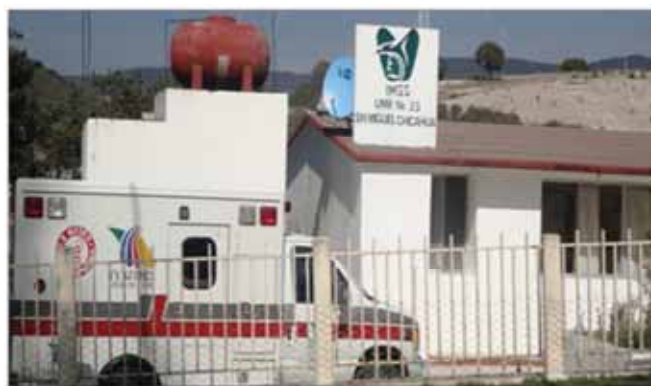
Fig.8 Instalación del Centro de Salud
