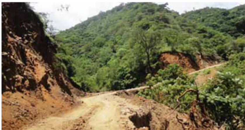
Figura 16. Carretera de terracería
