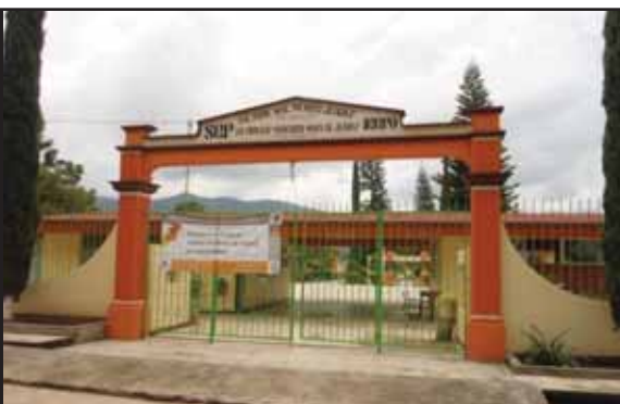
Instalación educativa de nivel Básico. ACCESO
