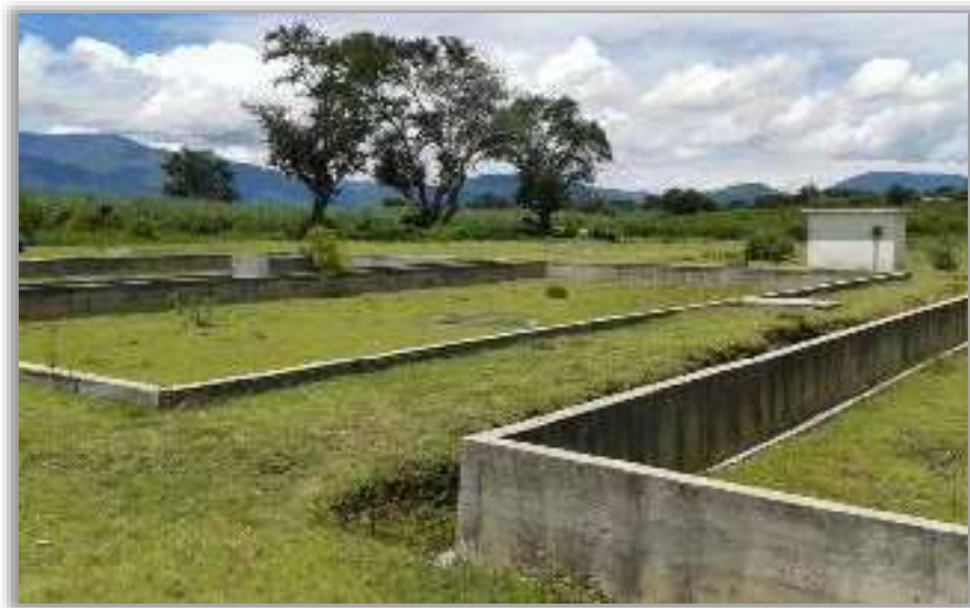
Foto 2. Planta de tratamiento de aguas residuales
