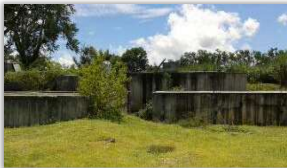
Foto 3. Obra inconclusa y abandonada
