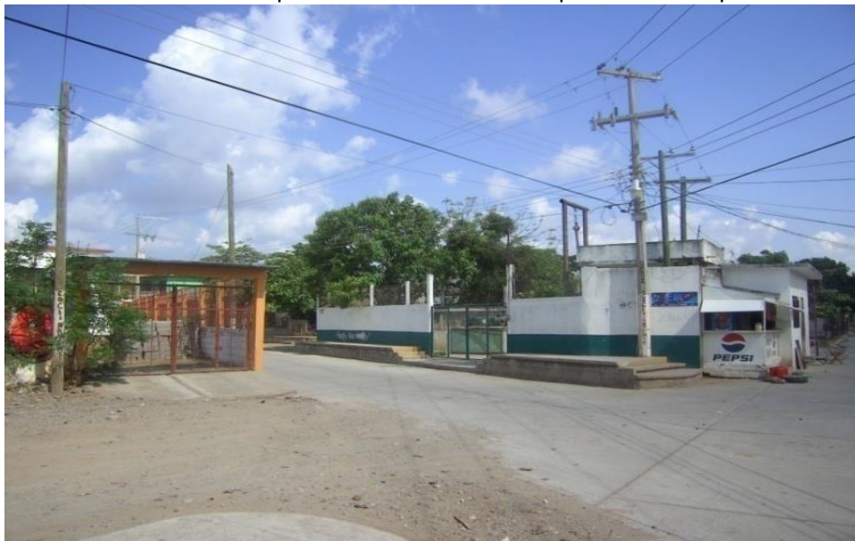
Foto 30. Pozo profundo No. 4 con una capacidad de 35 lps
