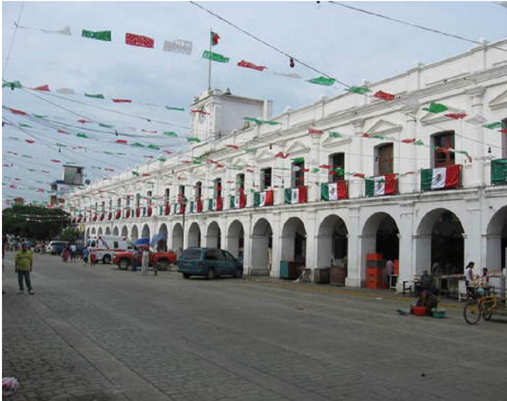
Foto 17. Palacio Municipal de Juchitán de Zaragoza
