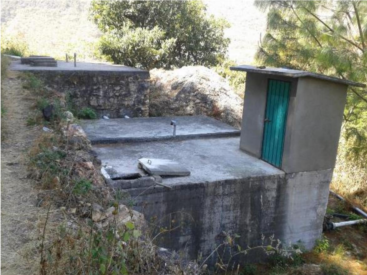
*Fotografía 6.- Tanques en el que se potabiliza el agua: filtración y cloración.*
