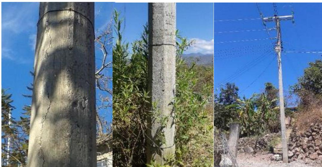
*Fotografía 7.- Postes de la red eléctrica agrietados e inclinados.*
