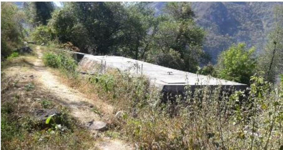
*Fotografía 21.- Tanque de almacenamiento dañado por el asentamiento de sus bases.*
