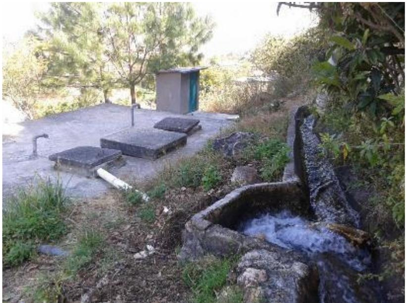
*Fotografía 5.- Agua transportada por canales a cielo abierto que abastecen los tanques de agua potable.*
