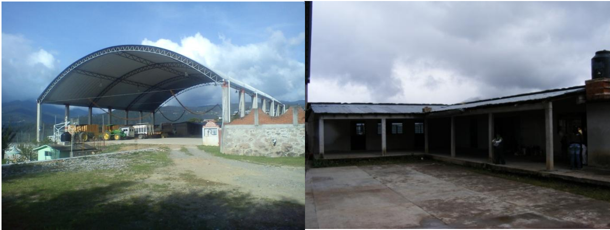
Figura 34.12. Casa del pueblo y auditorio municipal
