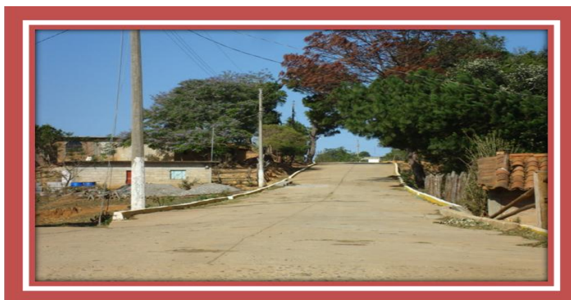
FOTO No. 21 CALLES PAVIMENTADAS, ENTRADA DEL PUEBLO
