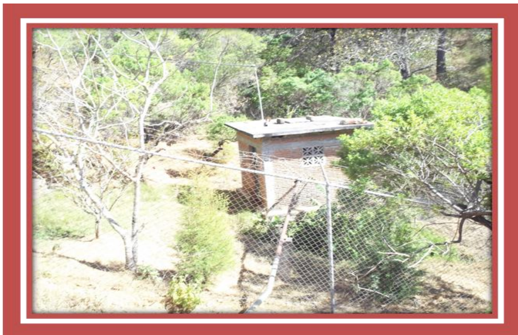
FOTO No. 5 CARCAMO DE BOMBEO DE AGUA
