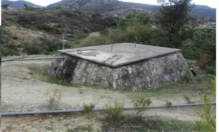
TANQUES DE AGUA POTABLE QUE DISTRIBUYEN EL LIQUIDO POR GRAVEDAD.
