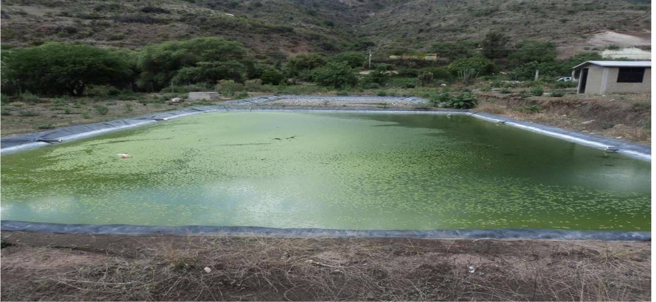
FOTOGRAFIA 12. Muestra un pantano artificial de la planta tratadora de aguas que no funciona.
