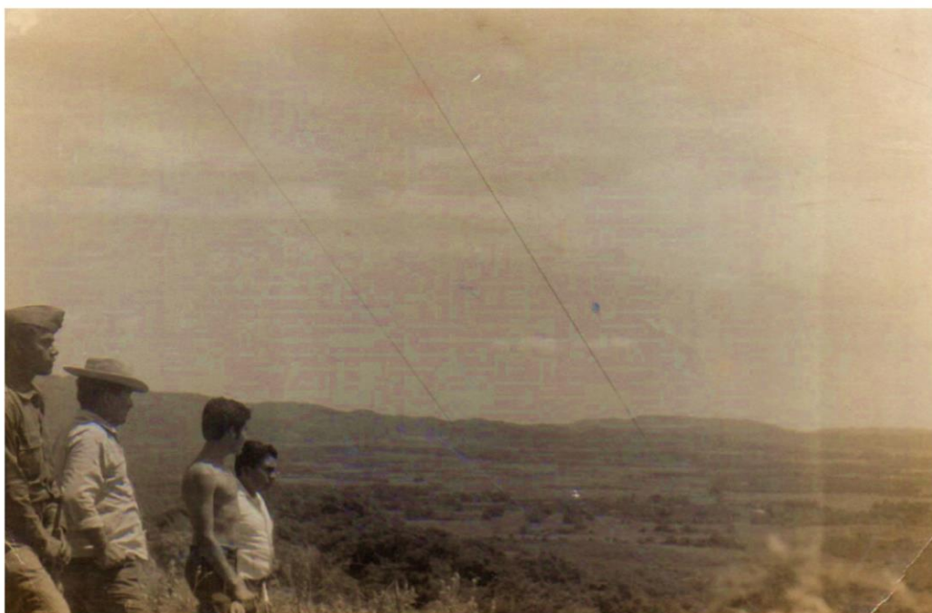
Observando y Planeando la apertura de la carretera a Tututepec
