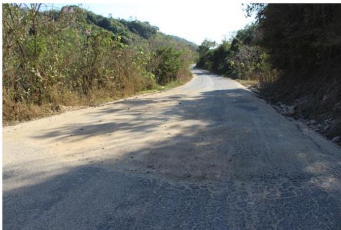
*Fotografía 3 Camino pavimentado en mal estado (Recorrido de campo 2014)*
