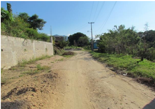
Placa Fotográfica Núm. 26 Muestra la red eléctrica de la cabecera municipal.
