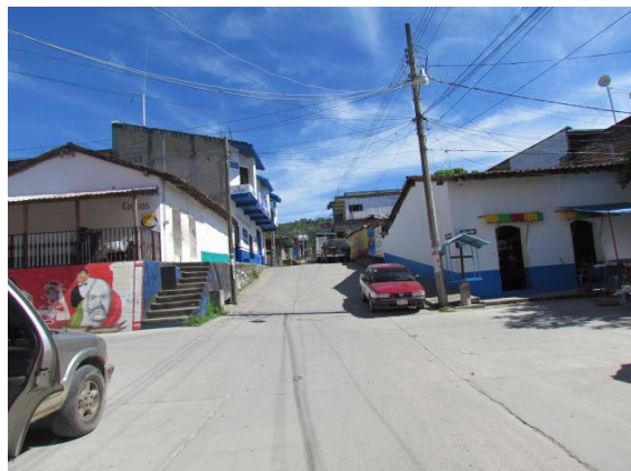
Placa Fotográfica Núm. 29 Muestra un camino de concreto hidráulico de la colonia centro.
