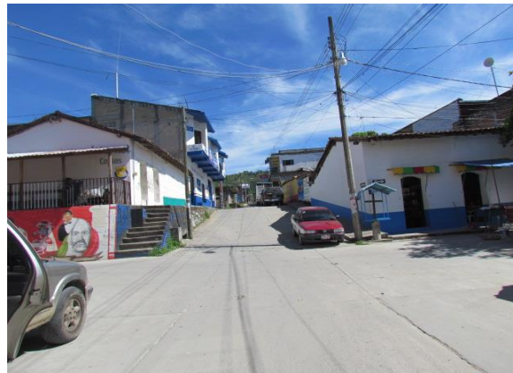
Placa Fotográfica Núm. 27 Muestra la red eléctrica de una ranchería cercana a la cabecera Municipal.
