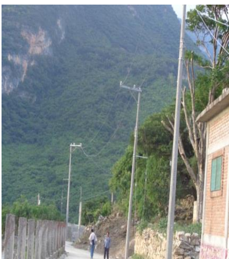
Fotografía No. 37. Infraestructura de electricidad
