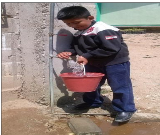
Fotografía No. 38. Infraestructura de agua potable.
