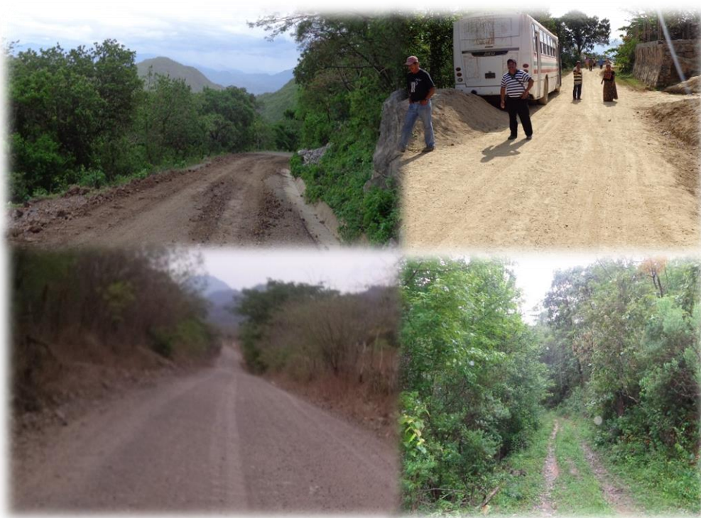
Fotografía No. 42. Infraestructura de caminos.
