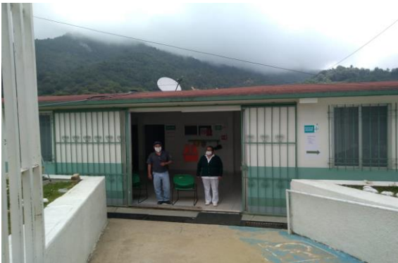
52.- Clínica del IMSS de la localidad de Santa María Tepantlali, fuente: fotografía propia de campo, fecha: 16/05/2020.
