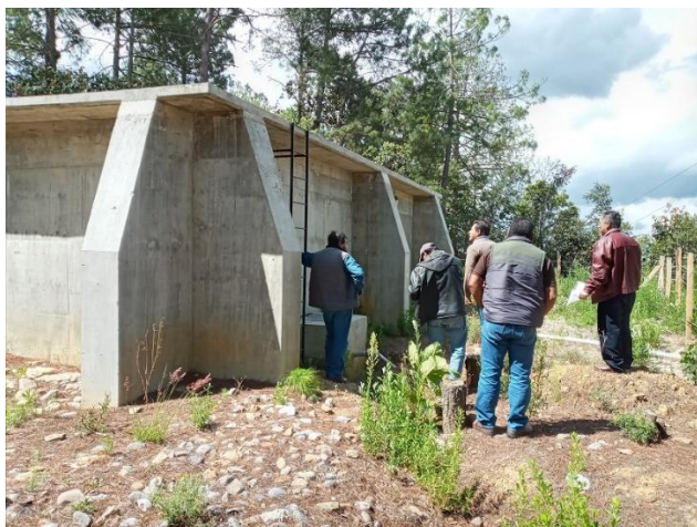
Visita a sistema de agua potable que requiere mejoramiento para hacerlo más funcional. 17 de mayo de 2020
