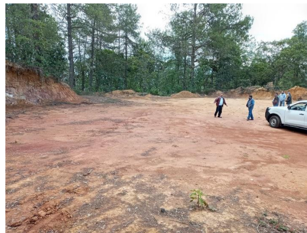
Visita a sitio para la construcción de infraestructura deportiva en El Punto. 17 de mayo de 2020
