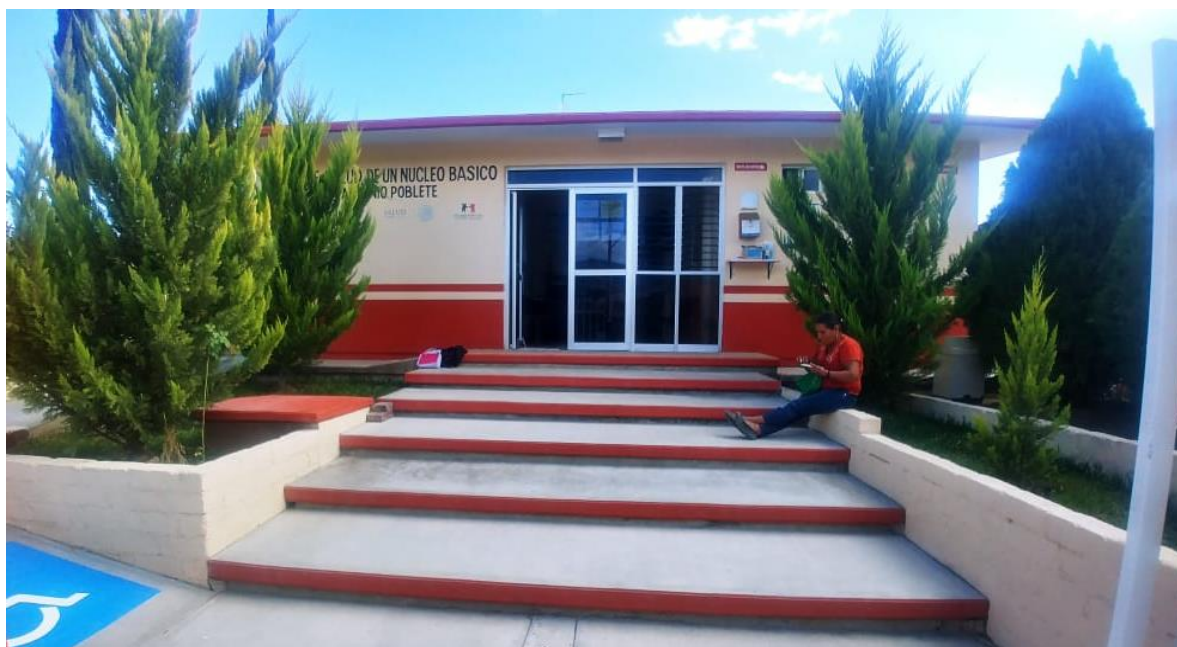
Imagen: Casa de Salud de la Localidad Poblete.
