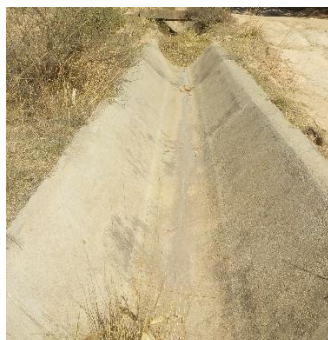
Canal de riego
