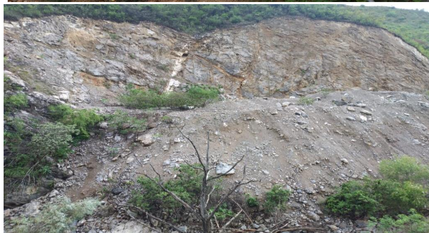
Espacio en el que se requiere el puente vehicular
