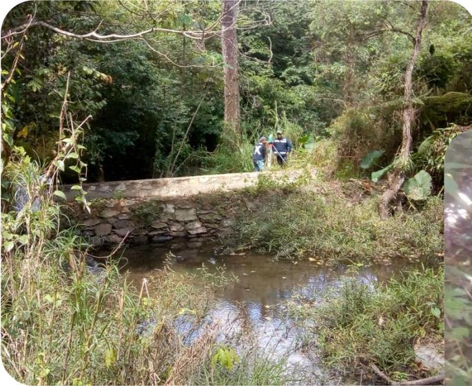
Imagen. 10 Captación expuesta a contaminantes La Reforma
