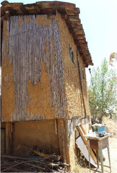
Foto 8. Infraestructura sanitaria de las viviendas del municipio.
