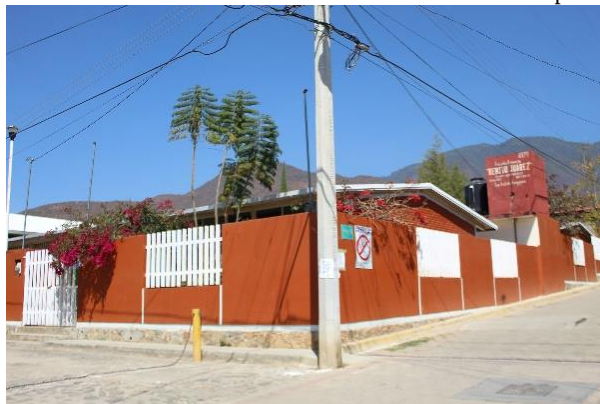
Foto 5. Infraestructura educativa existente en el municipio.
