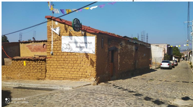
Foto 20. Vivienda destinada a la remodelación para indicar estatus.
