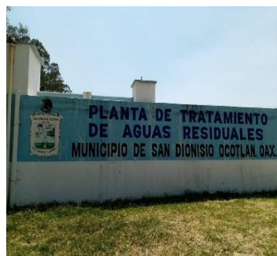
Ilustración 10. Planta tratadora de aguas residuales de San Dionisio Ocotlán.
