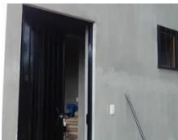
Figura 28. Área para la construcción de caseta de vigilancia
