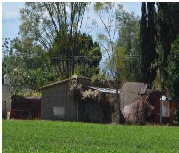
Figura 20. Viviendas de San Francisco Lachigoló Fuente: H. Ayuntamiento Constitucional
