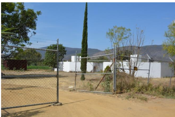
Figura 43. Infraestructura pública. Planta de Tratamiento de Aguas Residuales Fuente: H. Ayuntamiento Constitucional
