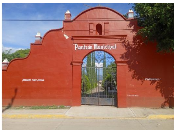
Figura 45. Infraestructura pública. Panteón municipal Fuente: H. Ayuntamiento Constitucional
