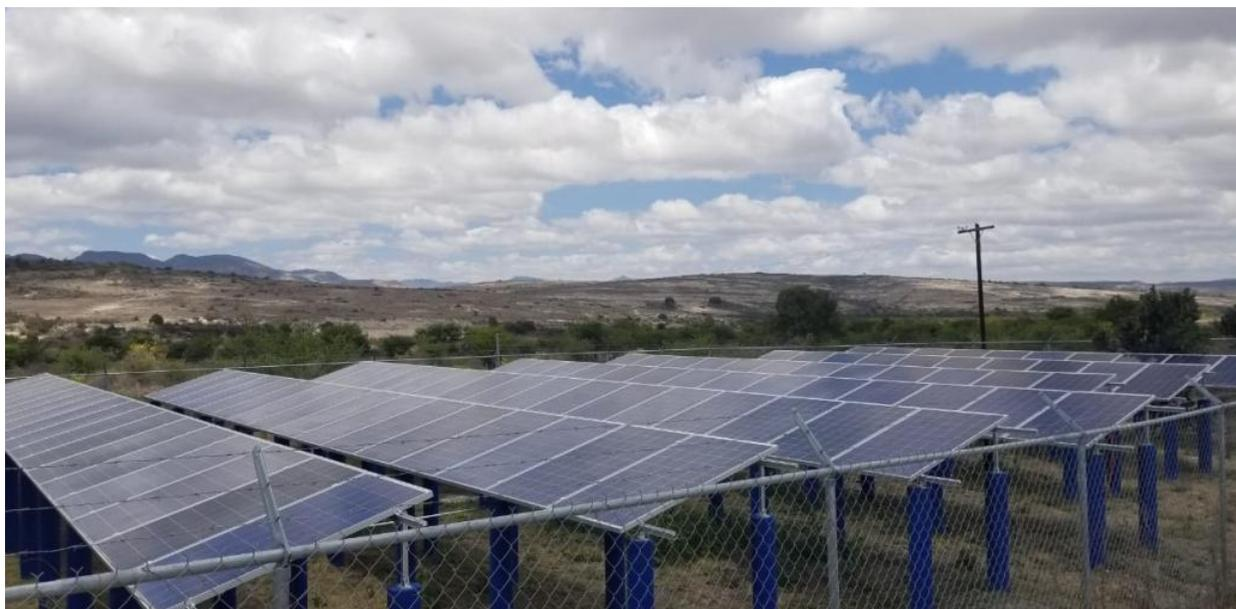
Imagen 57.- Paneles solares para sistema de distribución de agua potable
