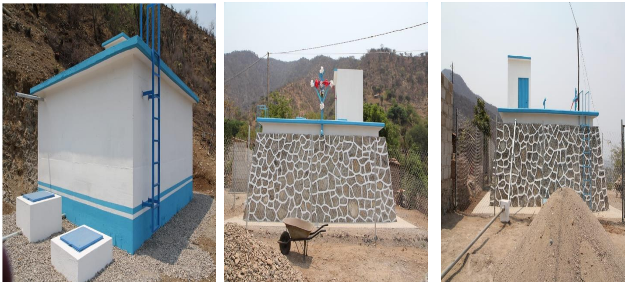
Fotos: Construcción de tanque de almacenamiento de agua en el Barrio el Mirador
