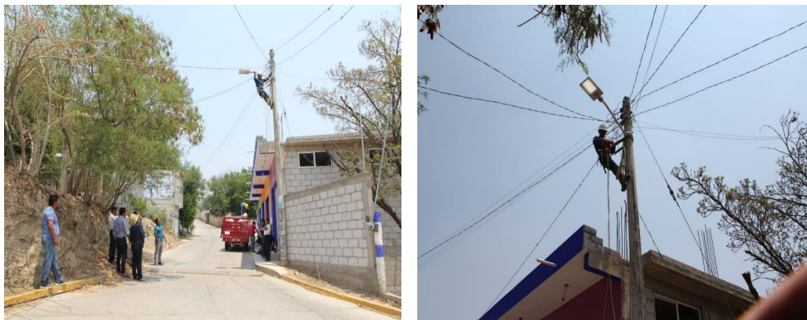
Fotos: Cambio de luminarias en las principales calles del municipio.
