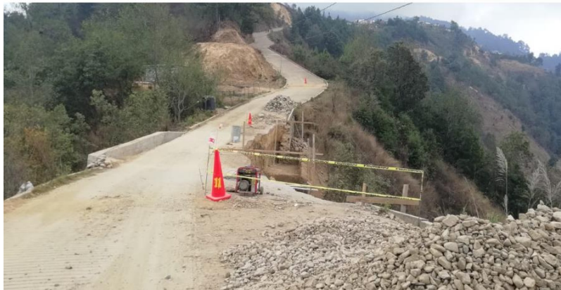
Obra: Construcción de muro de contención
