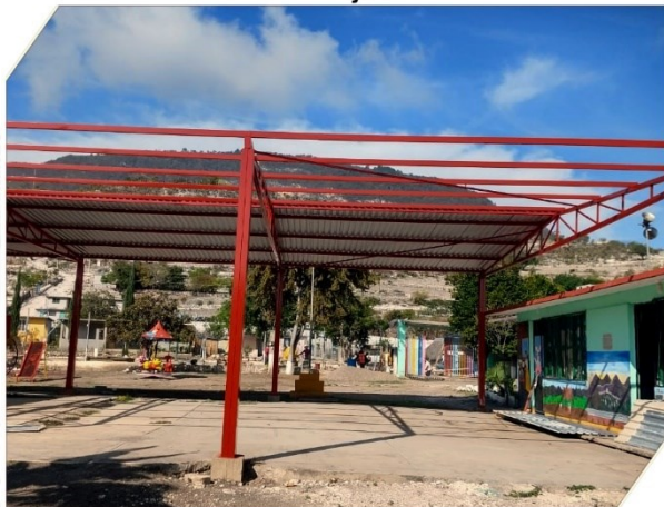
Foto. Flavio Gaytán Cuevas Obras en ejecución
