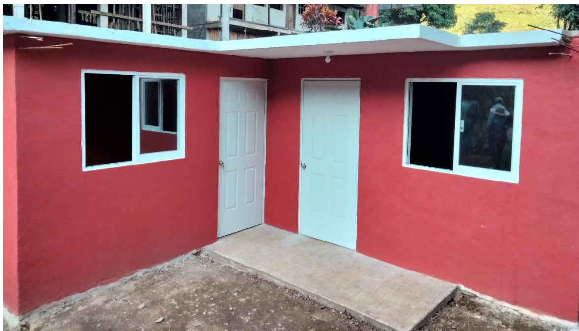
Imagen 17. Construcción de 5 viviendas en la Agencia de Moctezuma , San Pedro Sochiápam.
