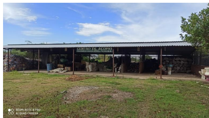
Figura XX Centro de acopio y almacenamiento de materiales reciclables
