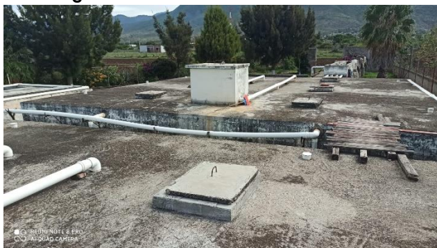
Figura XX Losa de reactor anaerobio
