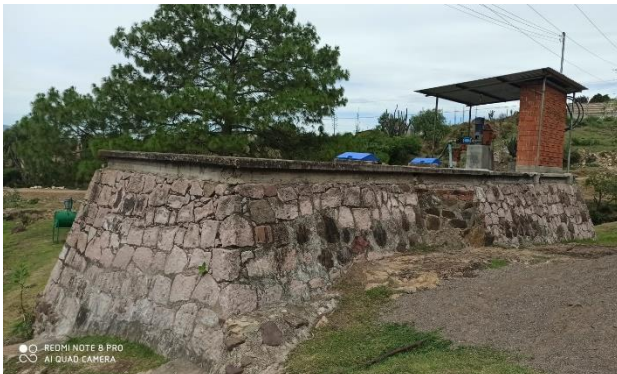
Figura XX Tanques de regulación de agua potable de mampostería en regulares condiciones
