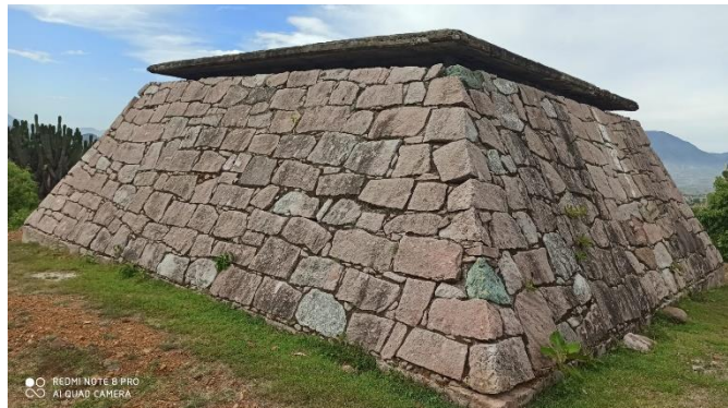
Figura XX Tanques de regulación de agua potable de mampostería en regulares condiciones
