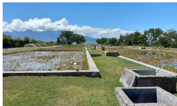
Figura XX Lagunas de oxidación para lodos
