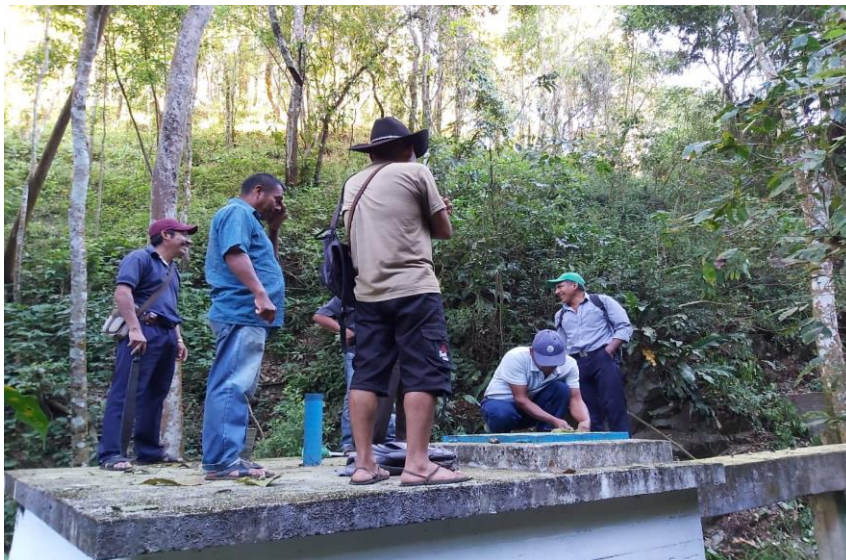
Foto: Infraestructura del agua potable en el municipio.
