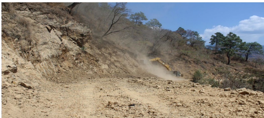
Figura 24 Ampliación de camino de acceso a la cabecera municipal
