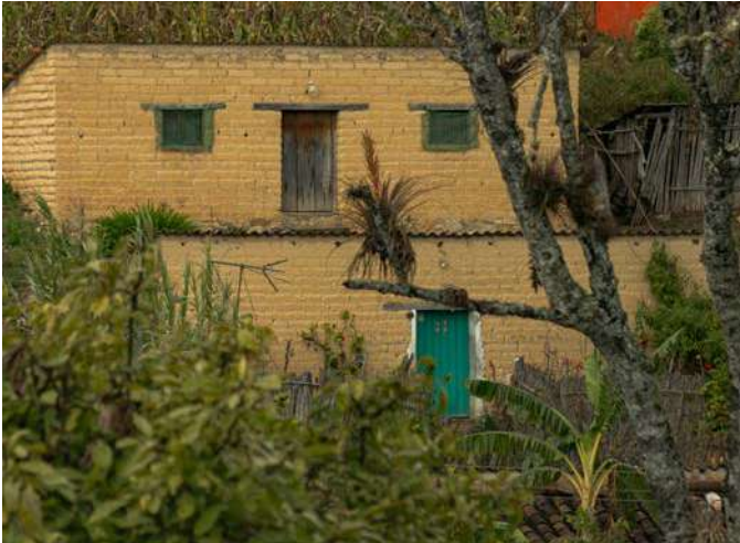
Fotografía. Viviendas ubicadas en Santiago Nacaltepec.
