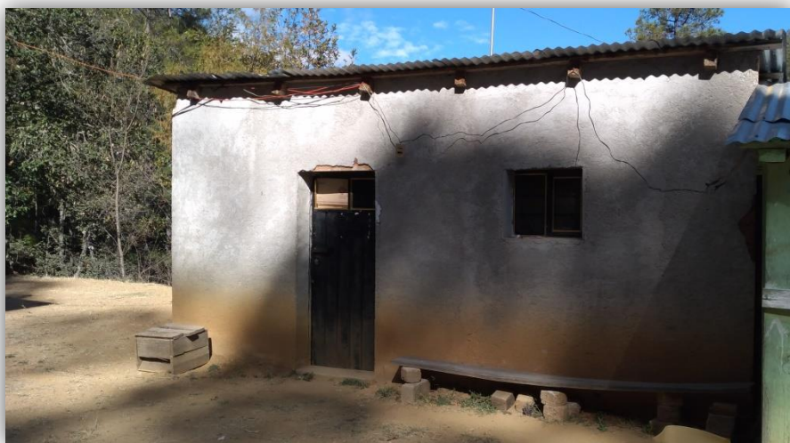
Foto 59. Viviendas de concreto y lámina
