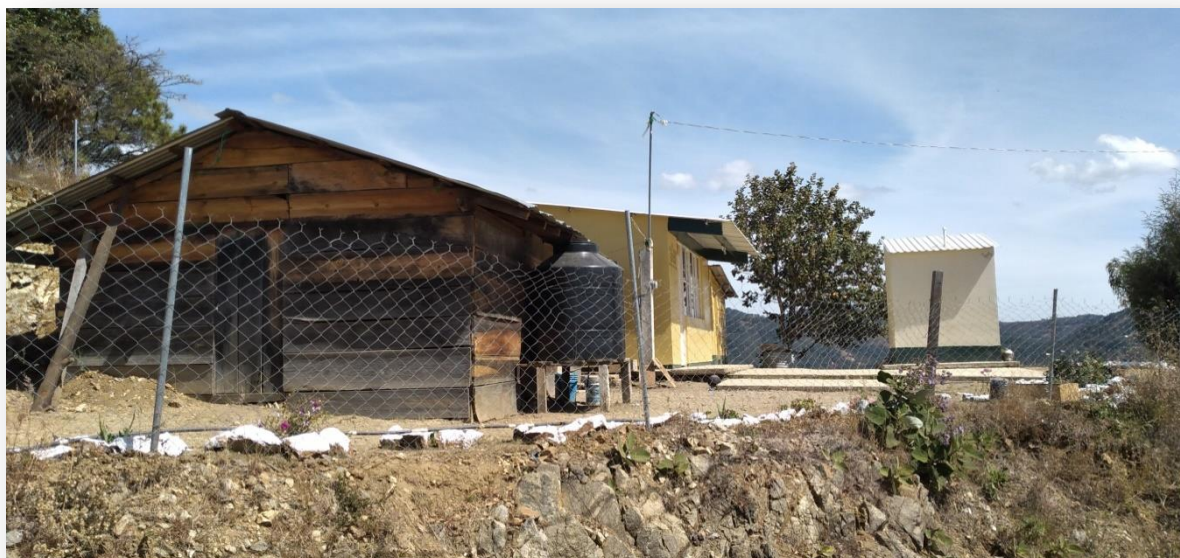
Foto 10. Escuela Secundaria Conafe Agencia La Muralla
