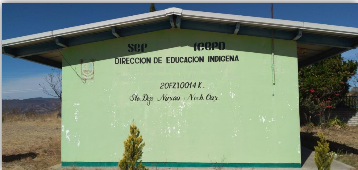
Foto 4. Supervisión Escolar municipio de Santo Domingo Nuxaá
