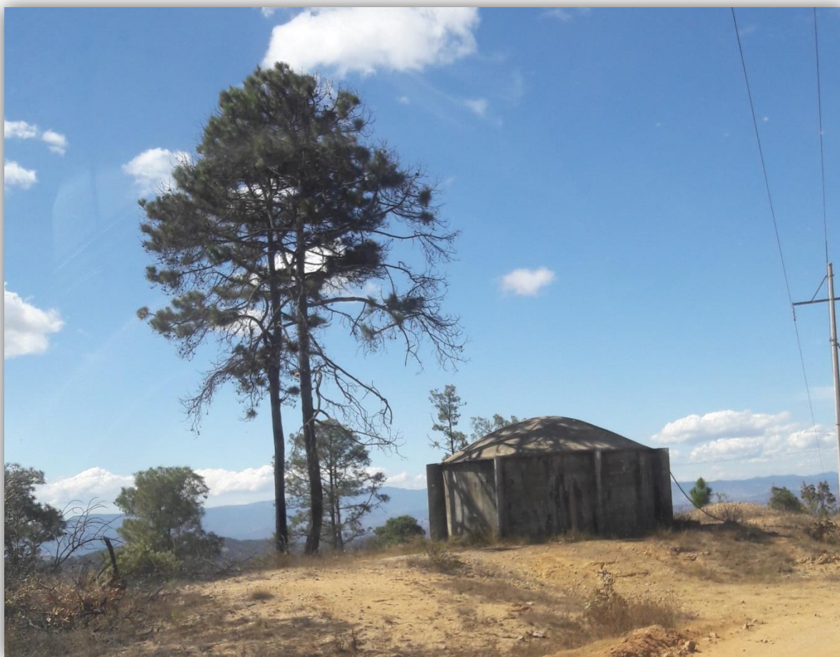
Foto 54. Tanque de almacenamiento de agua
