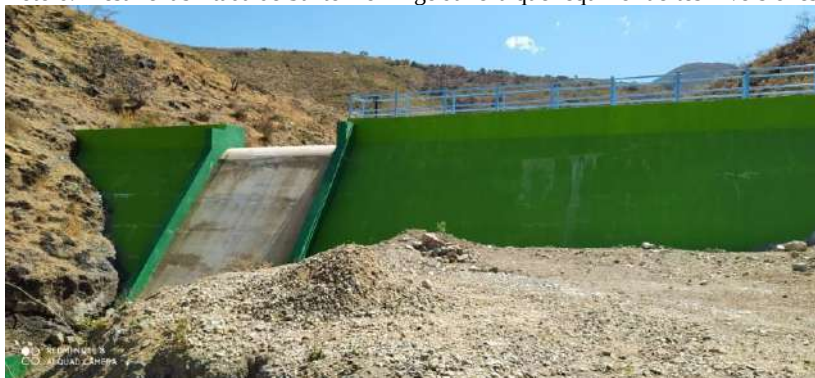
Foto 6. Presa rehabilitada de Santo Domingo Jalieza que requirió fuertes inversiones.
