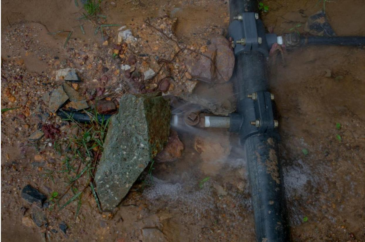
Imagen 23.- Fuga de agua en conexión de tubería de agua potable.
