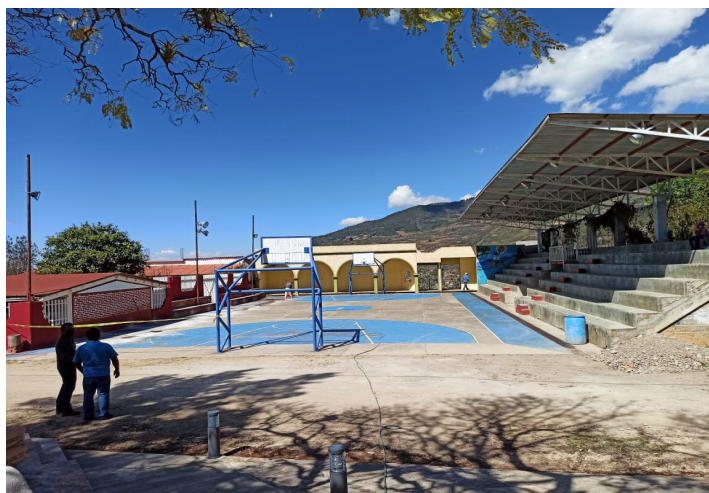
Imagen 28 Inicio de construcción techo cancha básquetbol
