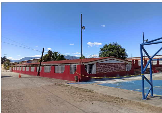
Imagen 29 Tramo faltante de pavimentar escuela primaria
