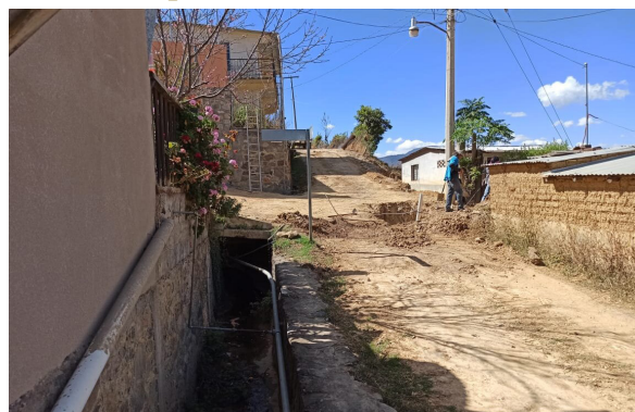
Imagen 27 Inicio de obra de pavimentación continuación camino a la escuela primaria
