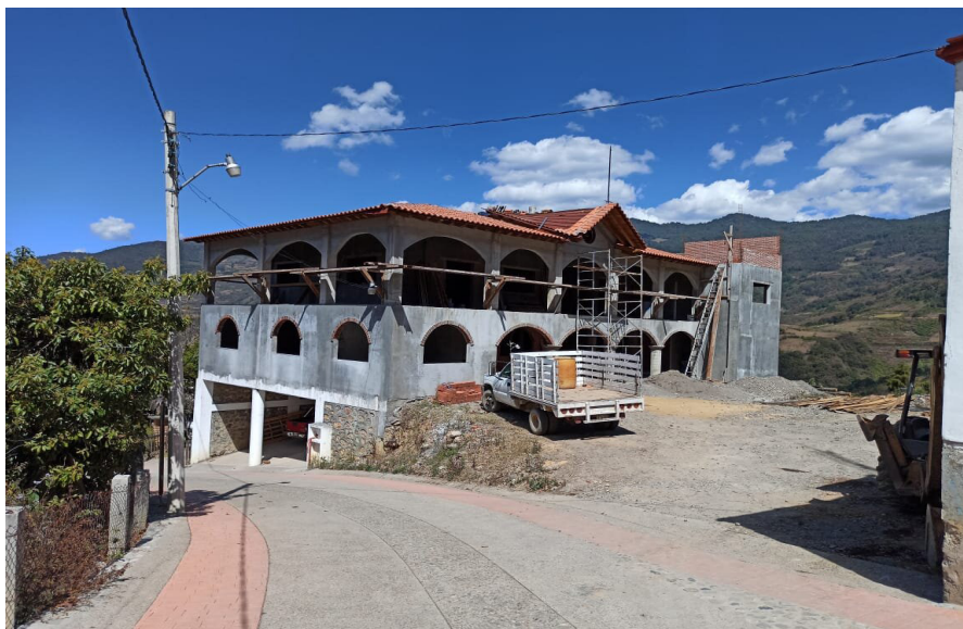
Imagen 21 Obras de rehabilitación y construcción de la casa de la cultura.
