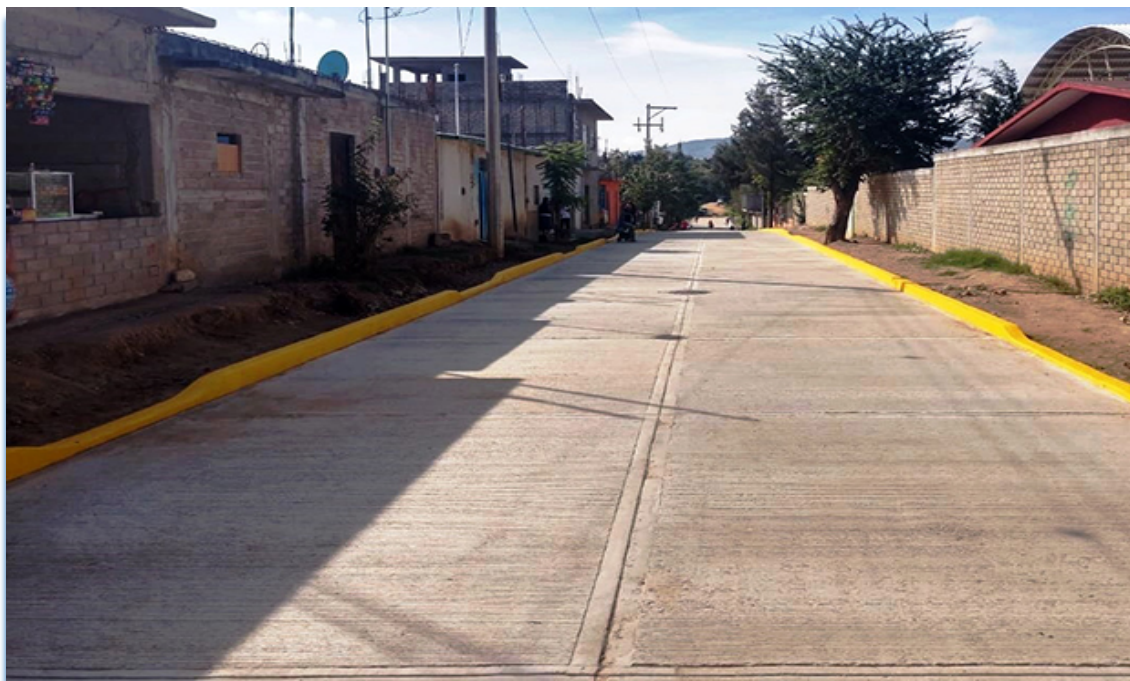
IMAGEN 32. PAVIMENTACIÓN A BASE DE CONCRETO HIDRÁULICO EN CALLE PRINCIPAL DE SAN JUAN DEL ESTADO.
