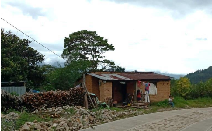
Vivienda típica con piso de tierra, muros de adobe y techo de lámina.
