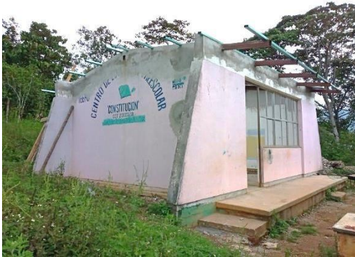
Aula del centro de educación preescolar de la Colonia Reforma en rehabilitación.
