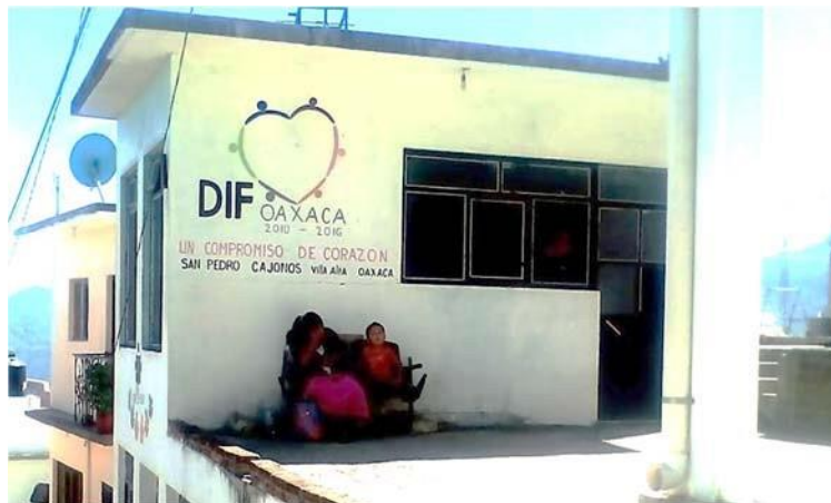
Fotografía 25. Instalaciones del centro DIF Fuente: Fotografía propia de campo.
