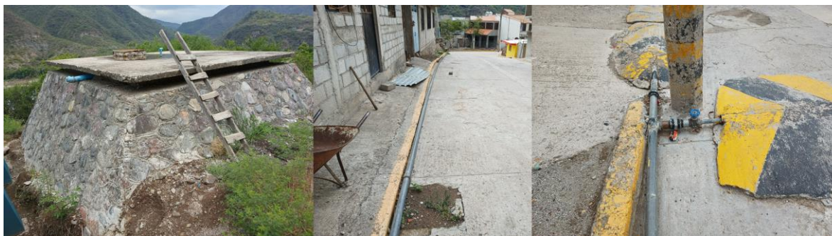
Imagen 13. Sistema de agua potable precario.
